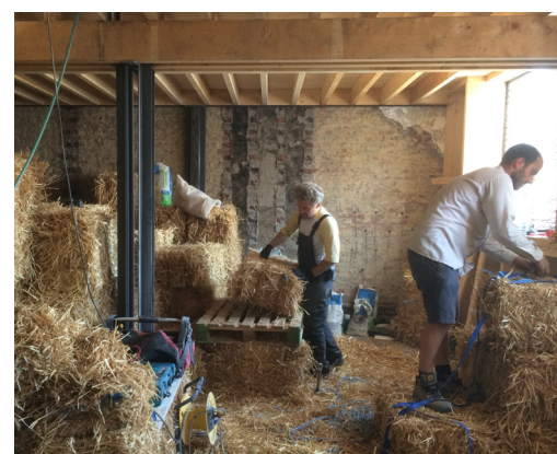
De geprefabriceerde houten cassettes werden ingevuld met stobalen van een Brusselse landbouwer. © Jasper Van der Linden
