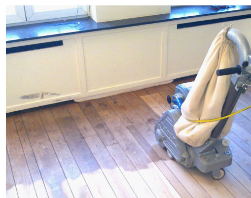
Bestaande elementen, zoals een oude plankenvloer, kan je (laten) opknappen of herstellen. © Joey Simons Vloeren
