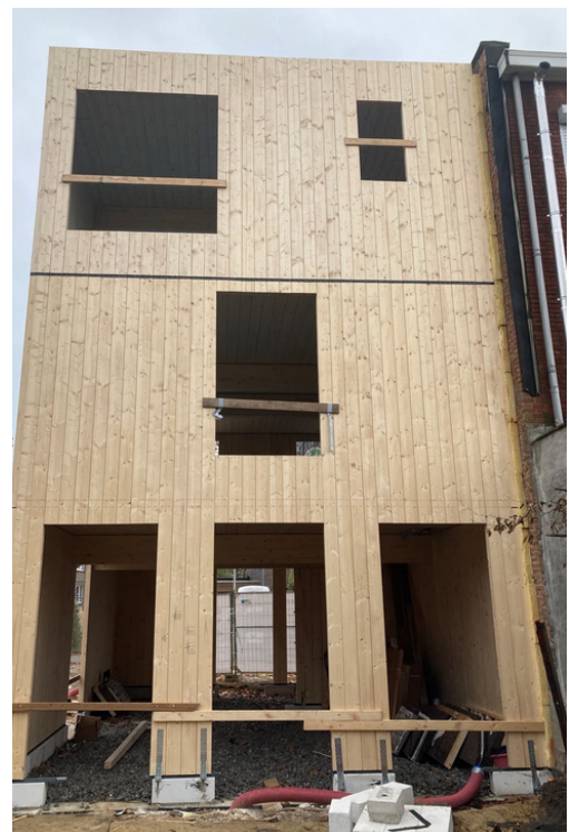
De buitenwanden van dit pilootproject zijn opgetrokken uit een demontabel houtschakelbouwsysteem van Systimber. © Circulair Bouwen, Betaalbaar Wonen
