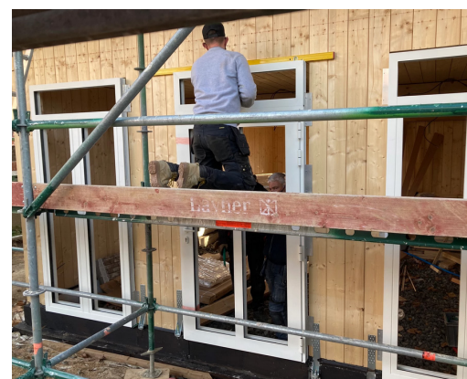
De buitenwanden van dit pilootproject zijn opgetrokken uit een demontabel houtschakelbouwsysteem van Systimber. © Circulair Bouwen, Betaalbaar Wonen
