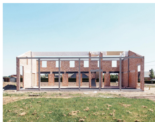
Kalkmortels en species met minder lijm laten toe om de bakstenen te hergebruiken. © KADERSTUDIO
